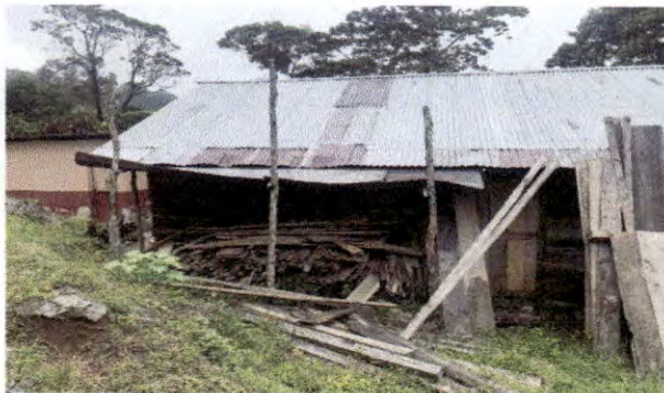
Foto 2: Estructura de techo de lamina en muy malas condiciones.
